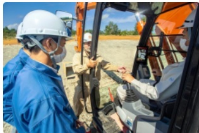
ICT建機の説明を受ける生徒（左）
