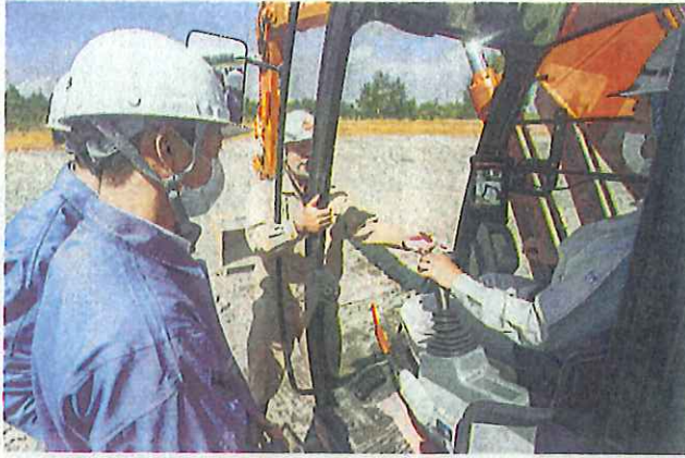
ICT建機の説明を受ける生徒(左)
