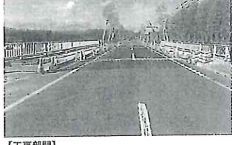
【工事部門】 新帯広空港線防B567改良泉橋補修
