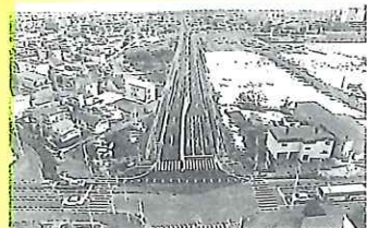
【工事部門】 3・3・10 共栄通ほか4千代帯広線総合開改良路盤・舗装
