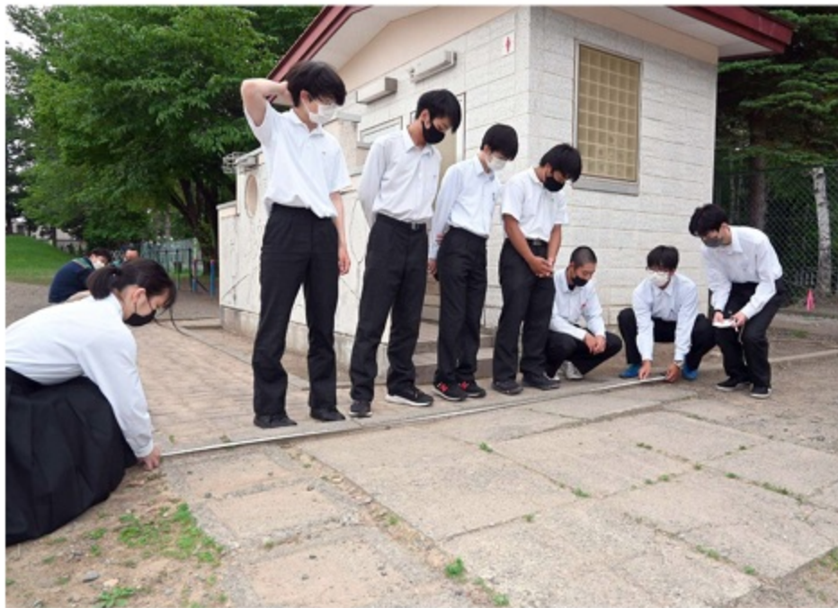
修繕に向け、稲田小のグラウンドのトイレ前のコンクリートの状況を確認する生徒
