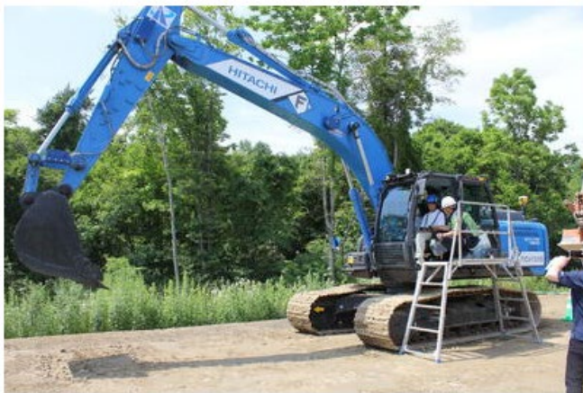
ICT建設機械の操作を行っています。
