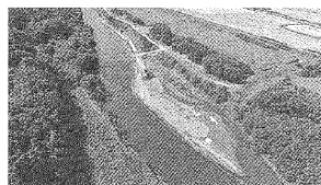
常呂川改修工事の内日吉 左岸上流掘削工事(磯谷 博) (磯谷口建設)
